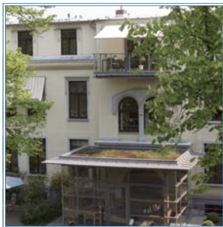
Neuer Balkon über dem Eingang
