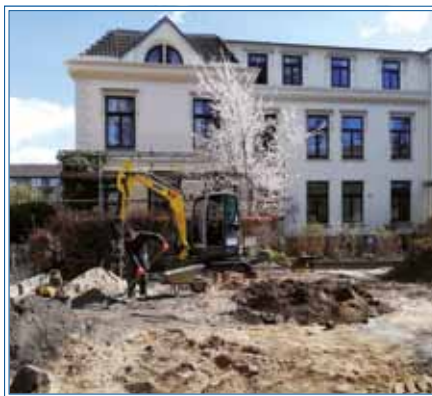
Arbeiten am Parkplatz
