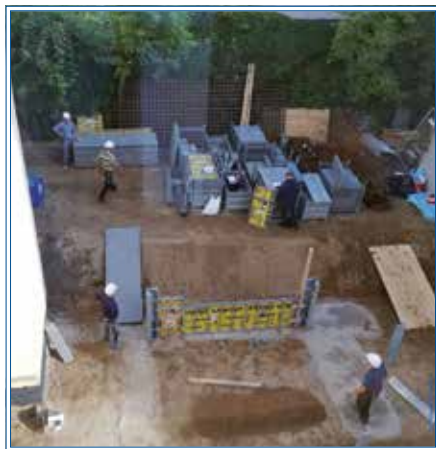
Bauarbeiten am Hospiz
