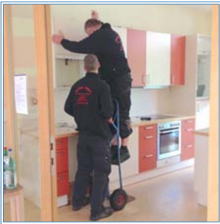
Umbau der Küche
